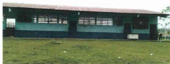
Foto 2: pintura en el muro exterior y interior.
