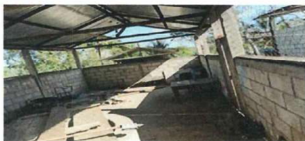
Foto 5: Ampliacion de cocina para el instituto.
