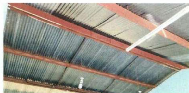
Foto 6: Mantenimiento de estructura de lamina.
