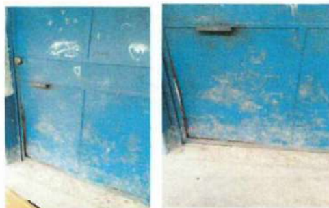
Foto 4: Sustitucion de puertas para aulas.
