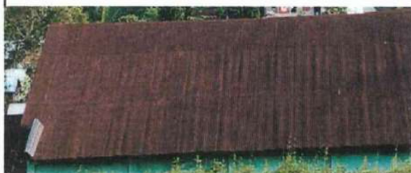
Foto1: Sustitucion de laminas del instituto
